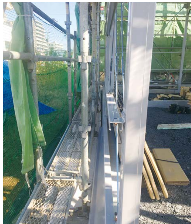
例：足場を使用した場合の施工状況①
