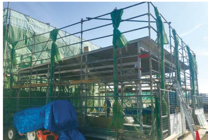
例：足場を使用した場合の施工状況②
